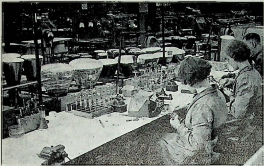
Fig. 1. Aan de montagetafels worden de binnenwerken der Philips kathodestraalbuizen gemonteerd, nadat de ballons met zware waterpersen op overdruk zijn beproefd.
